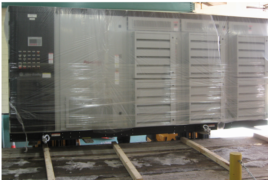
Рис. 5 – Подъём парой вилочных погрузчиков; обратите внимание на подъёмные балки и хомуты в основании привода
